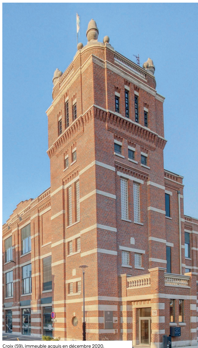
Croix (59), immeuble acquis en décembre 2020.
